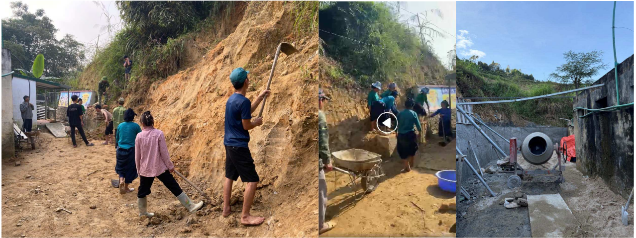
Phần khó khăn nhất là gia cố nền móng kê trên lớp đá rún
