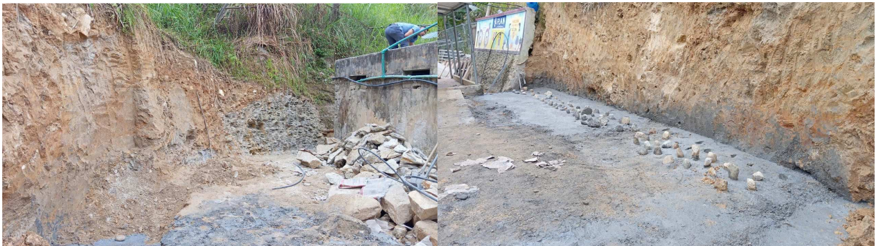
Phần thân kê sẽ được xây dựng nhanh hơn trên nền đã củng cố
