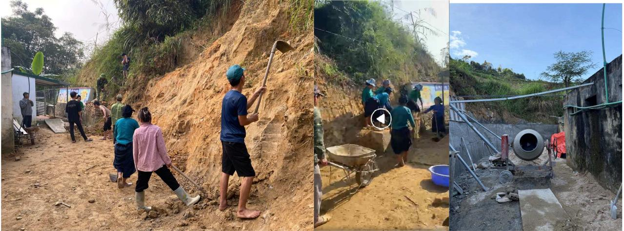
*La partie la plus difficile est de consolider les fondations de la base du remblai sur une couche rocheuse solide.*
